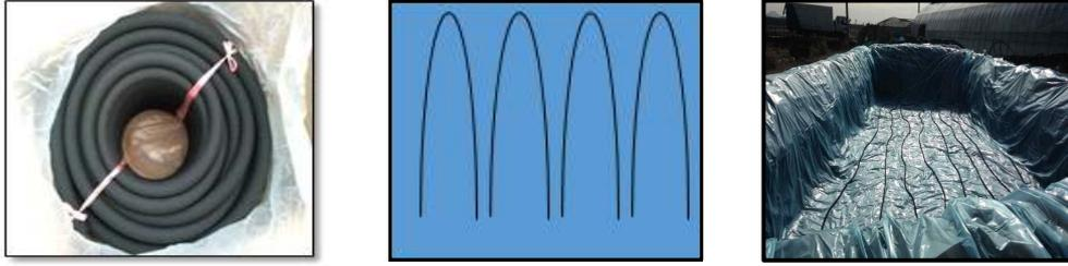
그림 8. 저압분산고무질호스(유니바이오토크스) 설치 모식도 및 설치방법
