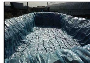
그림 8. 저압분산고무질호스(유니바이오토티스) 설치 모식도 및 설치방법
