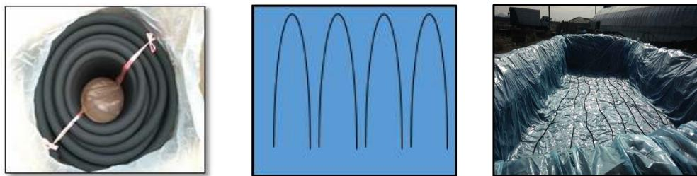
그림 8. 저압분산고무질호스(유니바이오호스) 설치 모식도 및 설치방법
