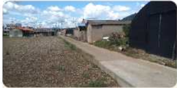
콘크리트 포장 농로
