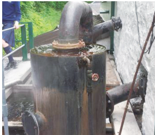
【그림 2-29】 웜 응축기(Worm Condenser)
